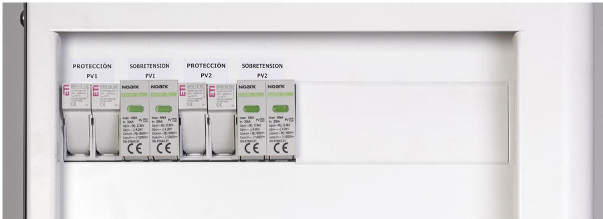
Ilustración 2. Protecciones de continua
